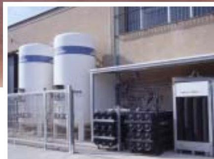
Sistema de suministro de gas de proceso, en tanque criogénico o bloques de comprimido
